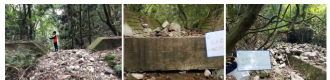
(c) 左:西側谷の砂防ダム満砂状態、中・右:東側谷の大広川に流れ込んだ土石の状態
